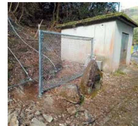
防護柵の隙間に設置
