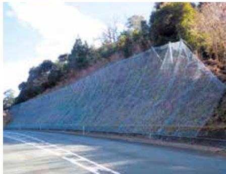
ポケット式落石防護網
