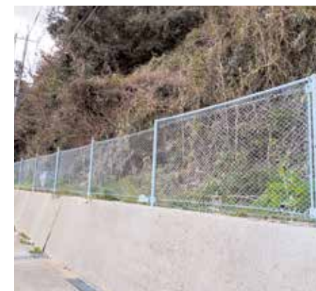
擁壁で防護柵の設置が困難な場所
