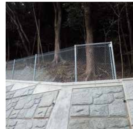
擁壁上に設置 (法肩部からの落石対応)
