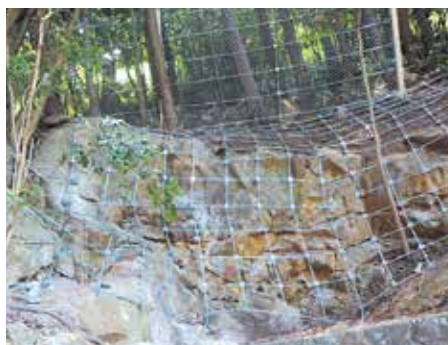
ロープ伏工 (クロスワイヤーネット)
