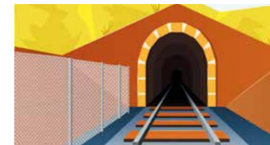
線路沿いの落石対策
