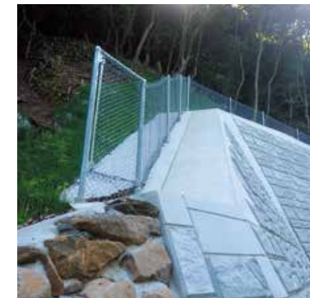
擁壁上に設置 (法肩部からの落石対応)
